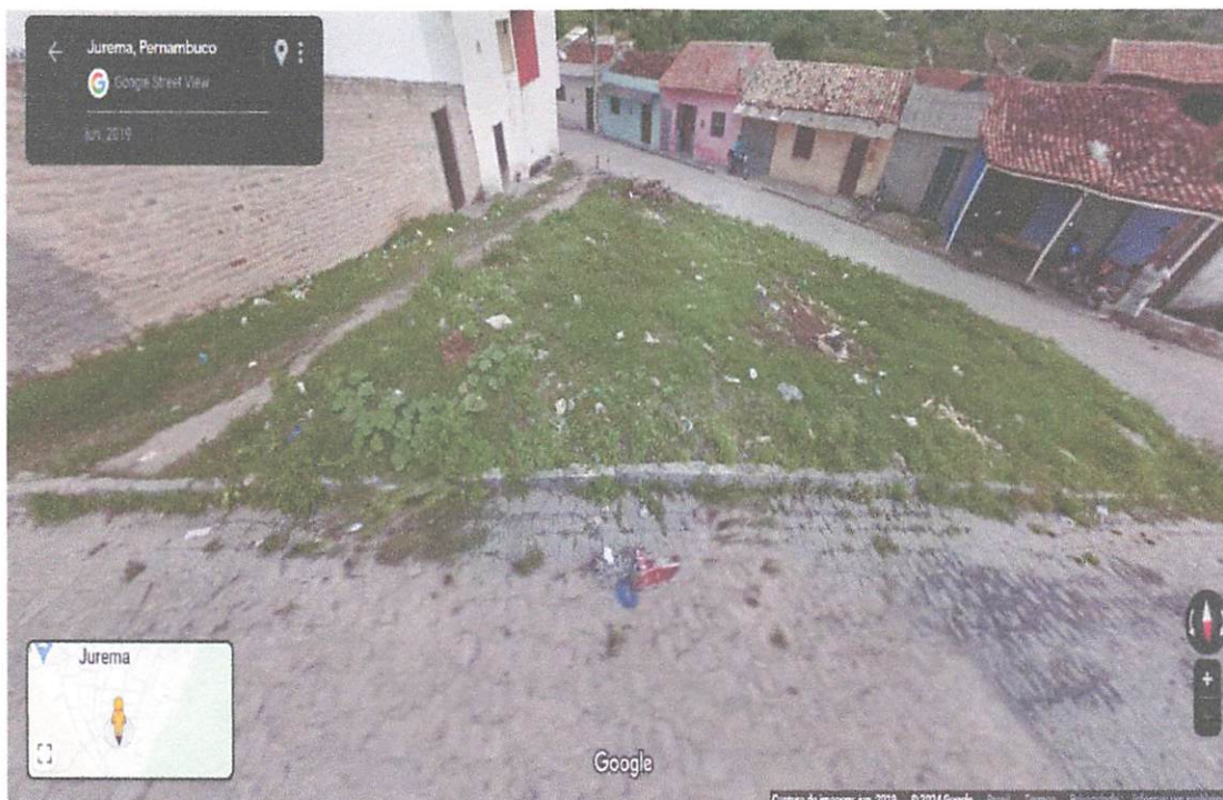
Figura 02: Terreno para construção da praça da Rua da Olaria
